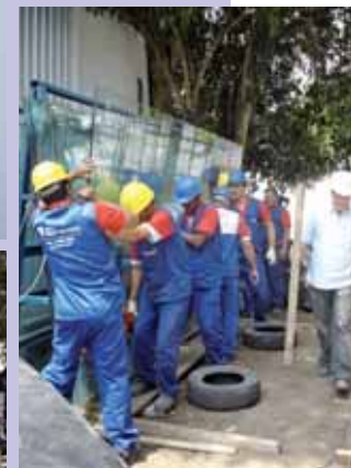
As peças de 328kg cada foram colocadas umas sobre as outras, para vencer uma altura de 7,20m
