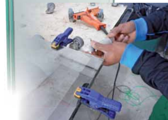
Segundo orientação da Foster's Química, se na resina FST 822 aplicada entre as lâminas de vidro ainda restar alguma bolha de ar, deve-se retirá-la com uma agulha de até 80cm
